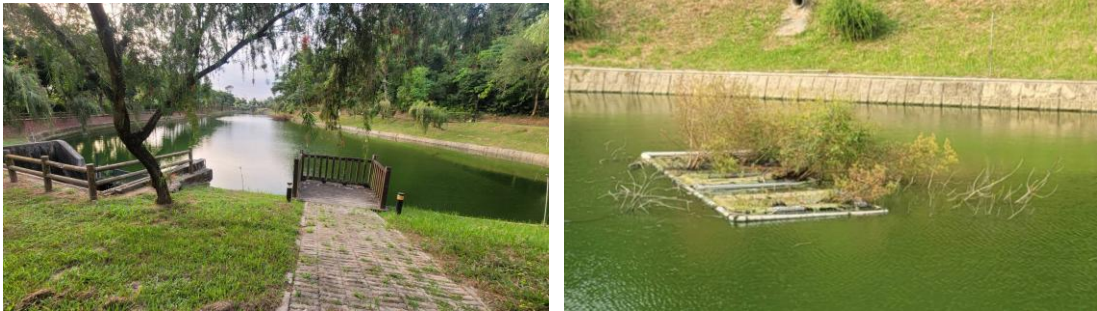
圖 6.28 南華大學橄欖湖營造生態棲地並設置水質淨化浮島淨化水質示範教學
