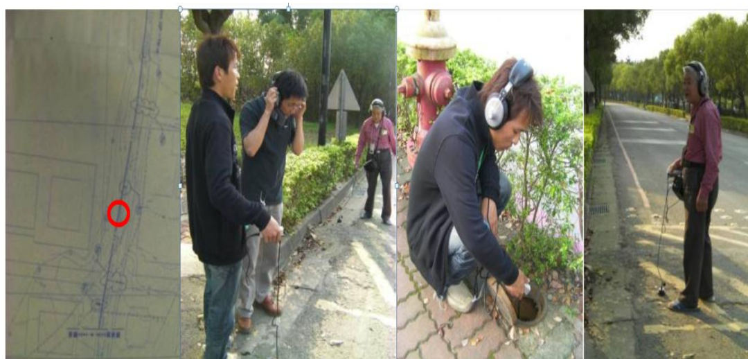
圖 6.7 自來水幹管查漏(紅色圈為可能漏水之處)
